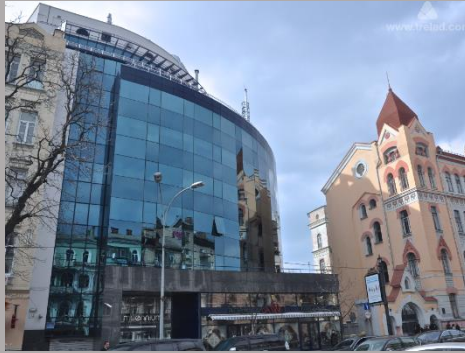
Реконструкция офисного центра "MILLENIUM" , г.Киев, ул.Владимирская 12 , 2009-2011
